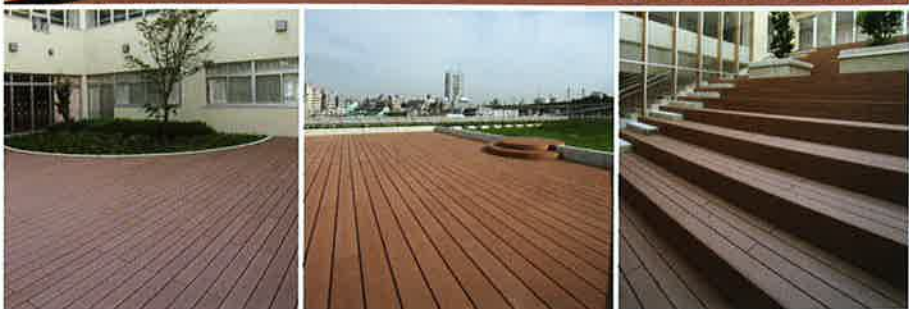
ウッドデッキ / 東京都北区立王子小学校・王子板中学校
