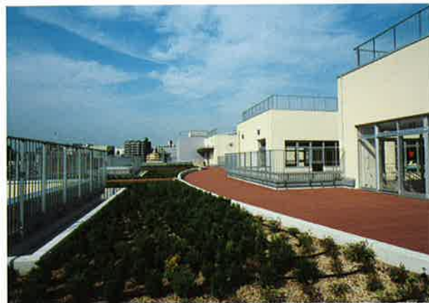
観察テラスは、実験や観察、さらに屋上菜園としても使用する校舎の緑化ゾーン
